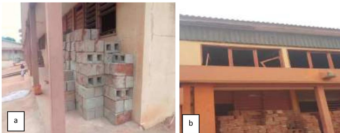
a: agglo de 15 creux pour les travaux pratique en maçonnerie; b: atelier de maçonnerie avec les agglos au rez-de-chaussée.
